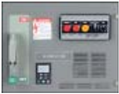
8998 ATV58 MCC Panel.tif
